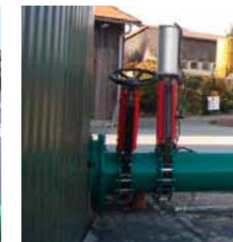
Direkteintrag vom Feststoff- dosierer in den Fermenter
