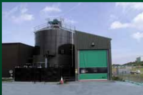
Kläranlage Newcastle, 500 cbm Schlammstapel-silo in emailierter Ausführung, Verladeleistung ca. 120 to/h; seitlich angeordnete, geschlossene Verladehalle
